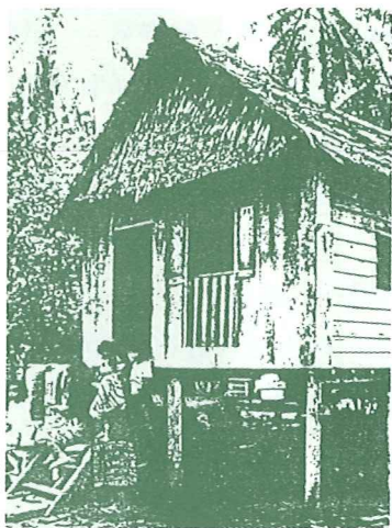
圖十七 印尼島BATAM島民宅，1992年 房屋建於椰子林內，取其遮蔭；居室開口甚多，取其通風。原始、實用、充滿生機！
